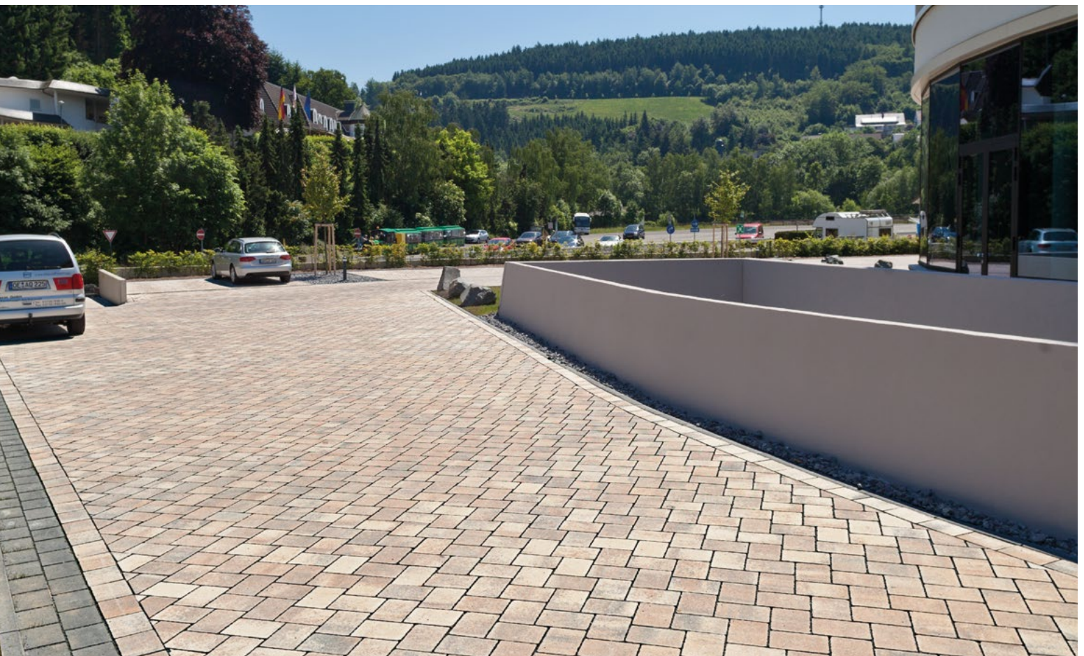
Fischgrätverband, geeignet bis Belastungsklasse Bk3,2
